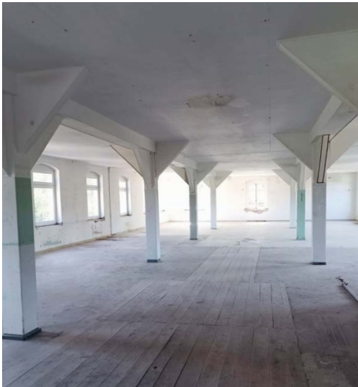
Durch nachträglich eingezogene Trockenbauwände soll in den offenen Hallen eine Binnenstruktur geschaffen werden. (Foto: Steve Urban)
