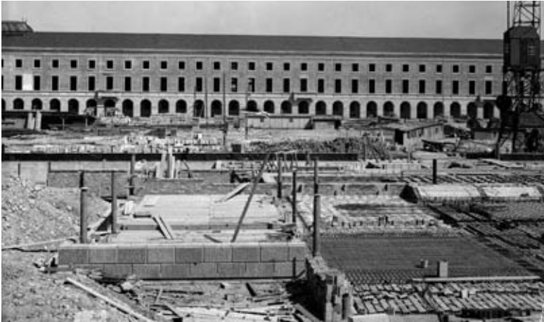
Hintergrund: Gebäude der „Gliederungen der NSDAP“ im Rohbau; vorn: Baustelle des „Gebäudes des Reichsstatthalters der Gauleitung“, 30. Juli 1939. (Foto: Stadtmuseum Weimar / Sammlung Eichhorn)
