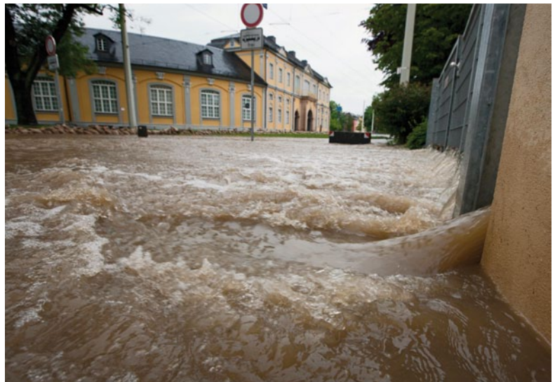
Das Hochwasser 2013 vor der Geraer Kunstsammlung in der Orangerie. (Foto: Steffen Weiß)
