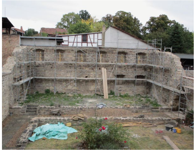
Aktuelle Baumaßnahmen zur Sicherung historischer Klostermauern. (Foto: Stadtmuseum Bad Langensalza)
