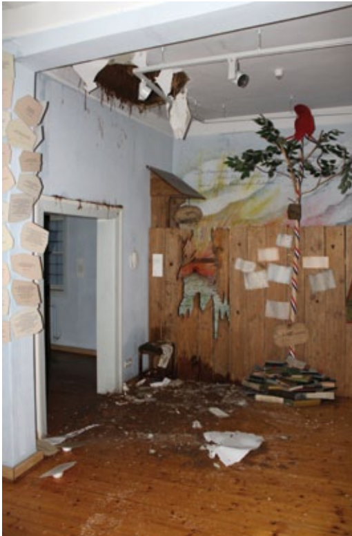
Schadensbild am Morgen des 12. Februar 2021 – besonders betroffen ist der Nordwestbereich des Gebäudes. (Foto: U. Häder, Städtische Museen Jena)
