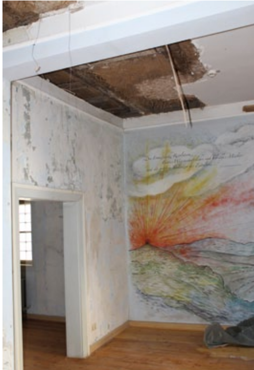
Geschädigter Ausstellungsraum nach Entnahme der durchfeuchteten Decken und Beendigung der Trocknung Ende März 2021. (Foto: U. Häder / Städtische Museen Jena)
