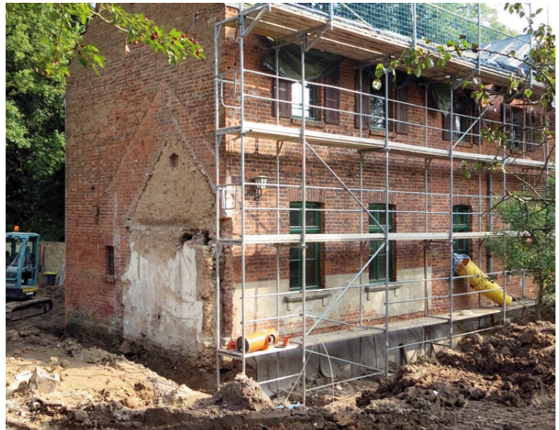
Beginn der Generalsanierung der Brehmschen Villa am 1.10.2014. (Foto: Jochen Süß, Brehm-Gedenkstätte Renthendorf)
