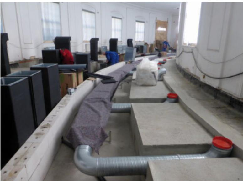
Einbau der Lüftungskanäle in der Orangerie. (Foto: Kunstsamm-
