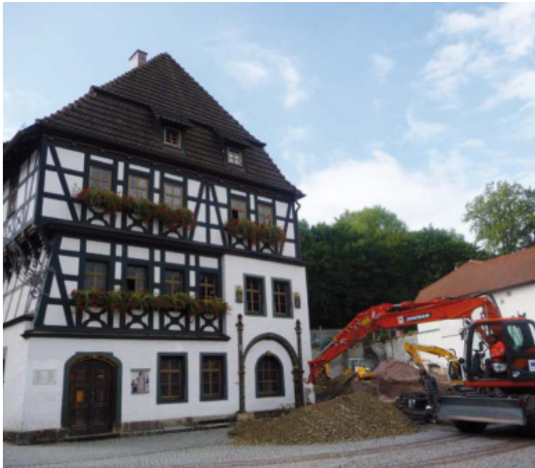
Rechts neben dem Lutherhaus sollen ein Verbindungsbau und ein Privathaus entstehen. Das Erdgeschoss nutzt künftig das Lutherhaus. (Foto: mip)
