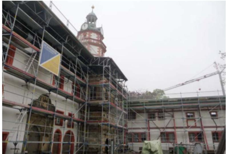
Nach dem Brand das Dach sichern, das Mauerwerk trocknen. (Foto: mip)
